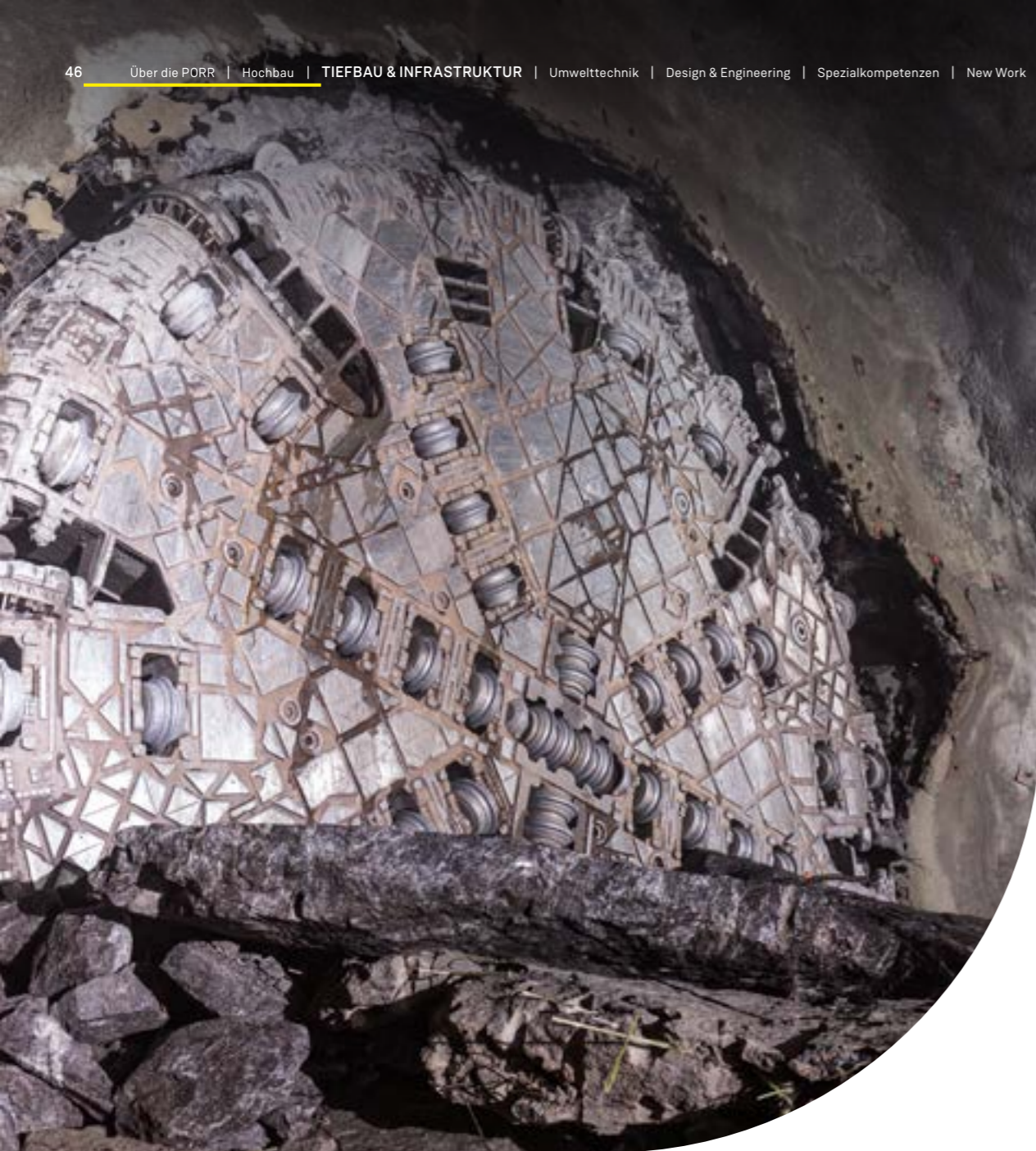
Bohrkopf einer Tunnelbohrmaschine
