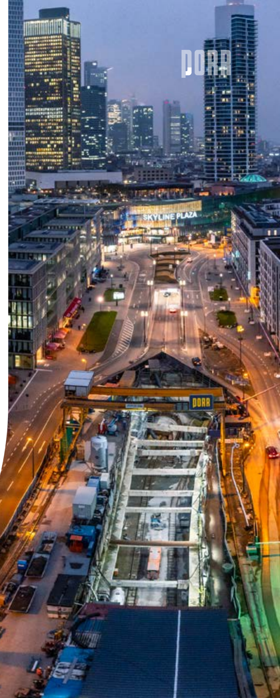
U5 Europaviertel Frankfurt am Main – Deutschland Bau einer unterirdischen Stadtbahnstrecke
