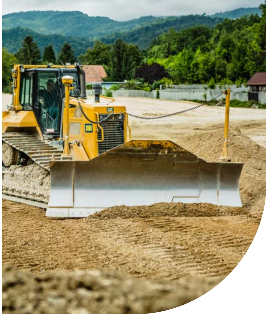
Hochwasserrückhaltebecken Fahrafeld/NÖ – Österreich Erdbauarbeiten beim größten Rückhaltebecken Niederösterreichs
